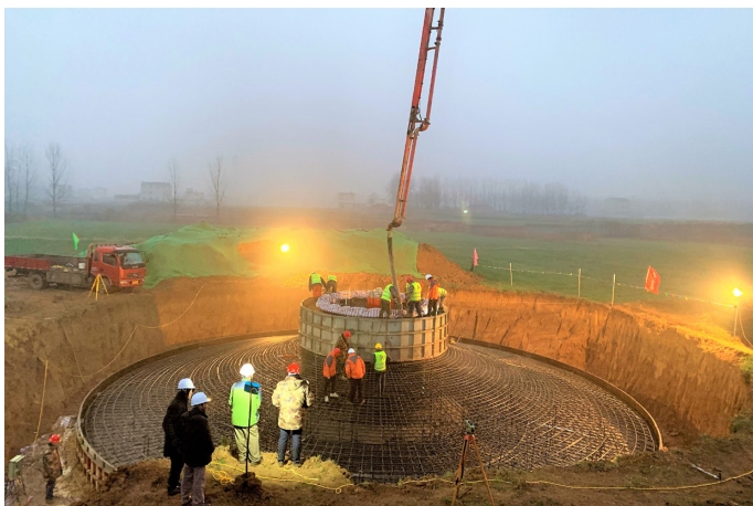
▲ 一等奖：蚌埠 30MW 风电项目风机浇筑 / 陈焕新
