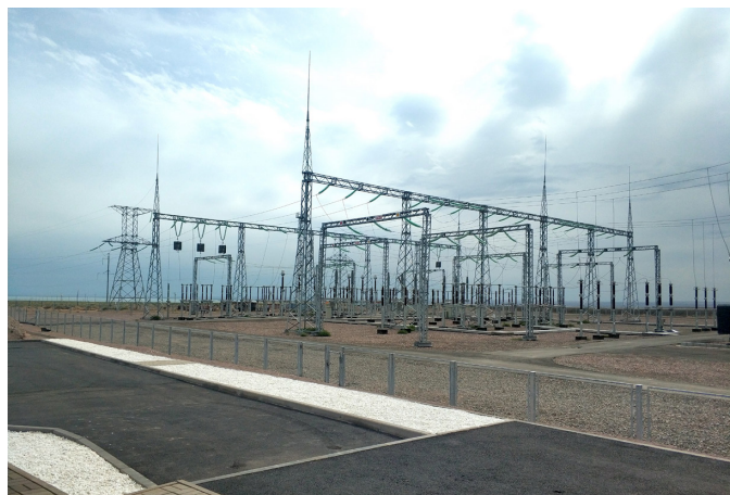
▲ 三等奖：卡普恰盖 100MWp 光伏电站升压站风貌 / 苏永伟
