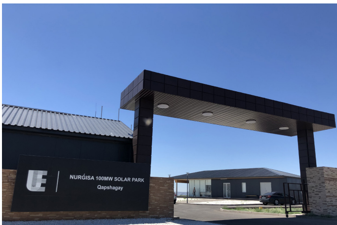
▲ 二等奖：卡普恰盖 100MWp 光伏电站 / 叶林
