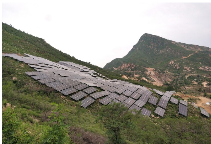
▲ 三等奖：灵寿项目光伏场区东侧全貌 / 苏永伟
