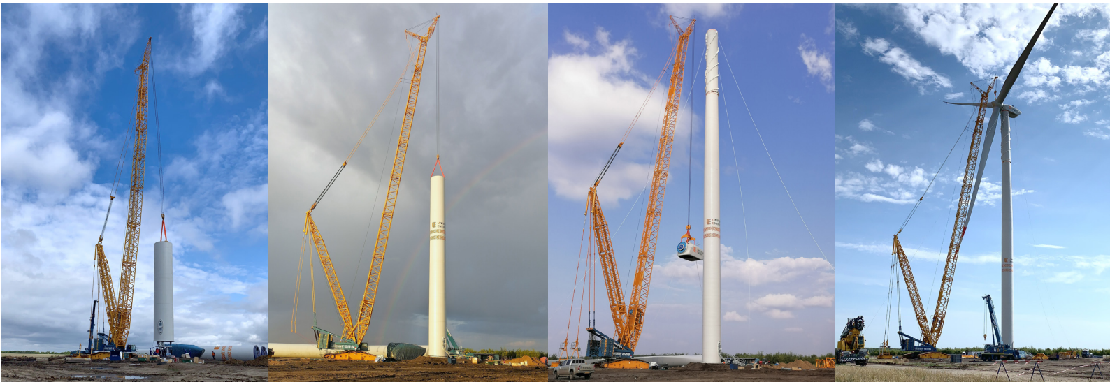
▲ Ybyrai 50MW 风电项目 7 号风机吊装现场
