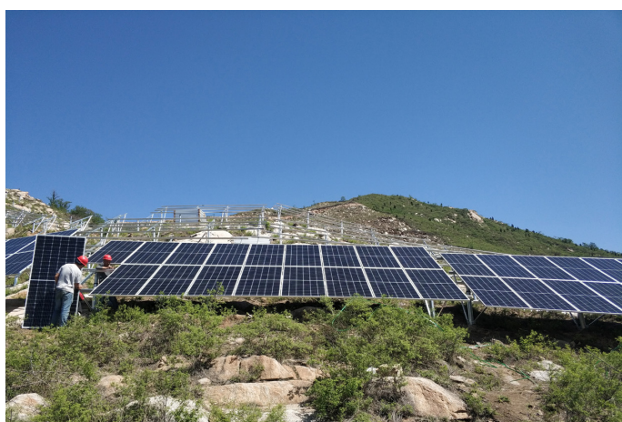
▲ 三等奖：灵寿项目组件安装 / 苏永伟
