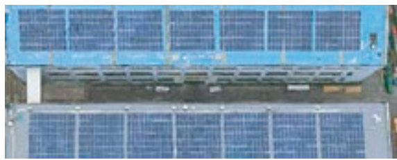
温州13.67MWp屋顶光伏项目
