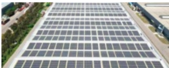
河南26.85MWp屋顶光伏项目
