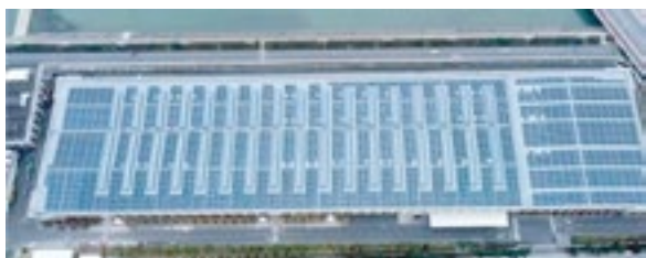
绍兴12.42MWp屋顶光伏项目
