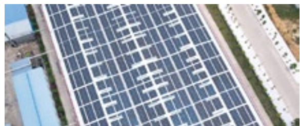
广西1.94MWp屋顶光伏项目
