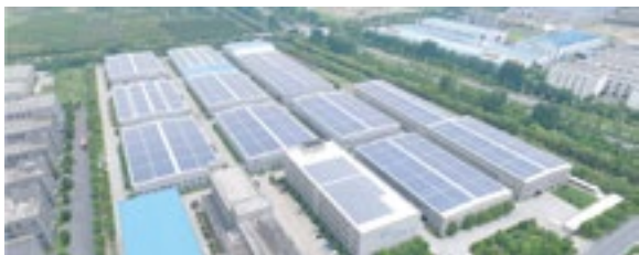
杭州84.29MWp屋顶光伏项目
